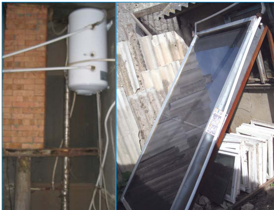
Colectorul solar și boilerul – două sisteme simple, pentru apă caldă pe gratis
