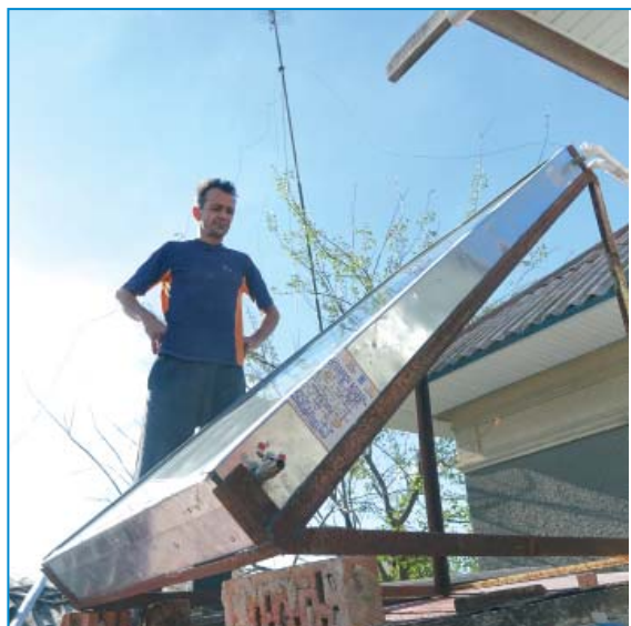
Colectorul solar a fost instalat – apa caldă nu va mai fi un lux
