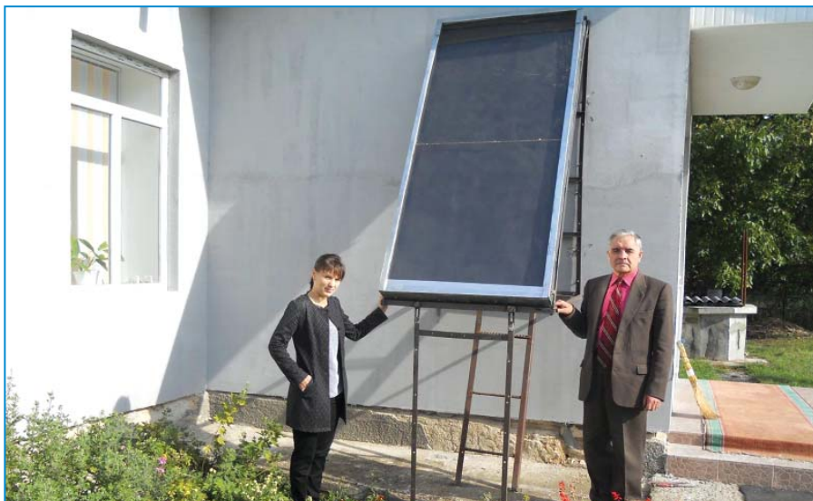
Colectorul solar de la grădinița din Viișoara
