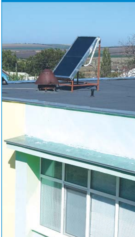
Colectorul solar a fost instalat pe acoperișul grădiniței
