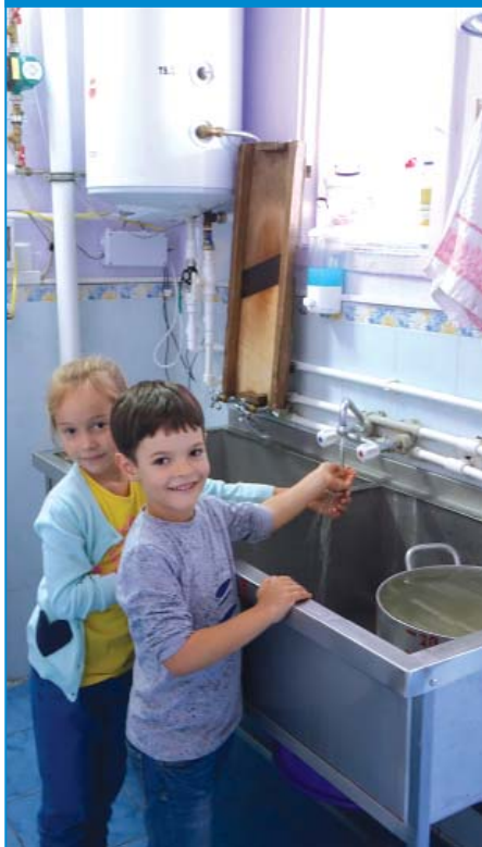
„Colectorul de raze” aduce apă caldă în robinete
