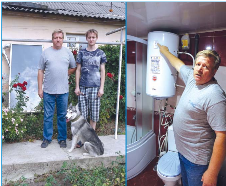
Colectorul solar și boilerul din gospodăria lui Andrei Scvorțov
