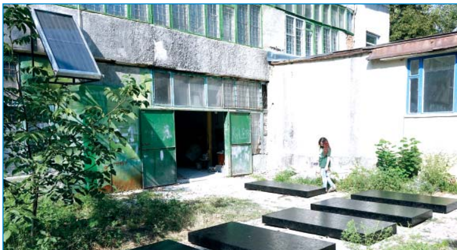
Cadranle viitoarelor colectoare solare – după vopsirea în culoarea neagră, acestea se usucă la soare
